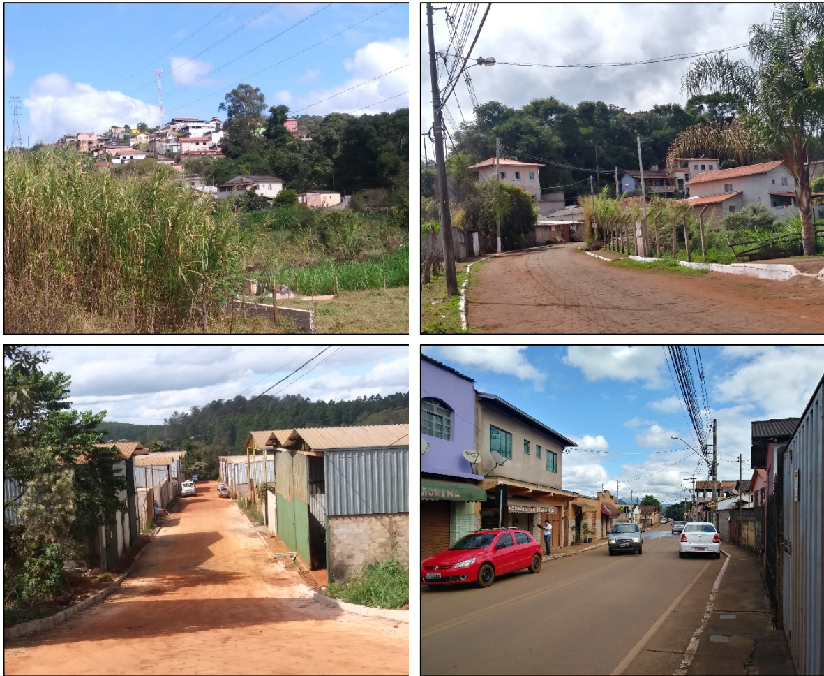
Foto 93 - Aspectos gerais das ruas e da paisagem do bairro São José.
