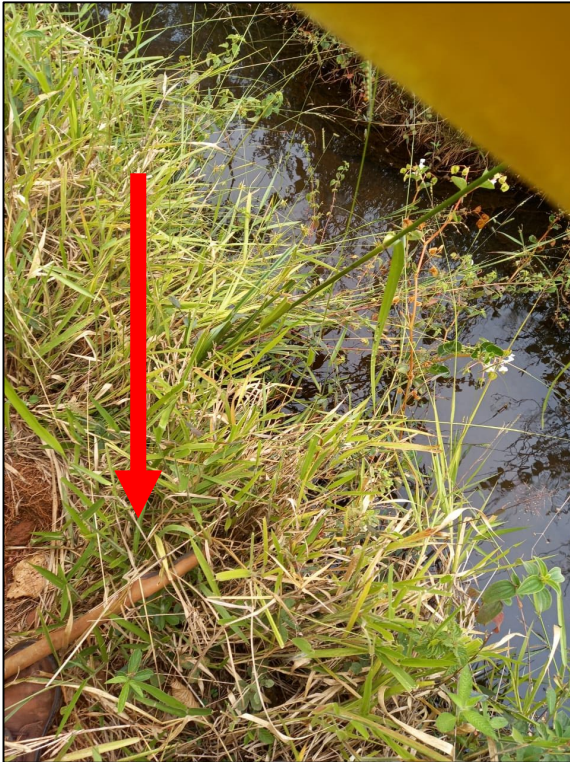
Foto 2 – Captação de água em situação irregular Fonte: Geomineral, 2021
